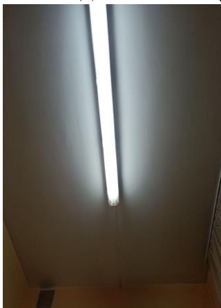
3.9. Подснежники (потолок буфетная, умывальная)
